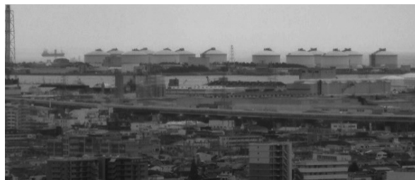
大阪ガス泉北製造所のLNGタンクが見える
