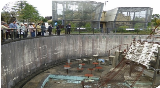
取り壊される予定のサル島
